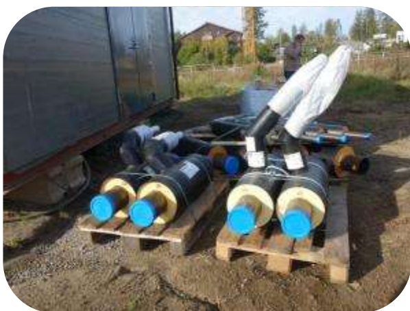
Obrázok 18: Izolácia tepelných rozvodov
