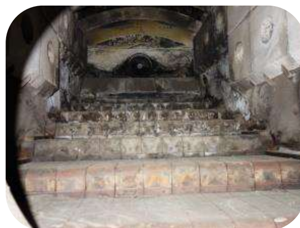
Obrázok 21: Spaľovacia komora kotla
